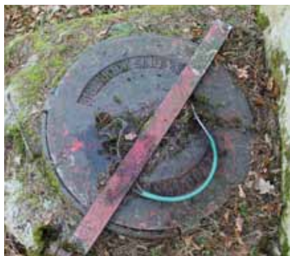
Zachowana do dziś dawna pokrywa studzienki kanalizacyjnej firmy Hainricha Schevena z Düsseldorfu.
