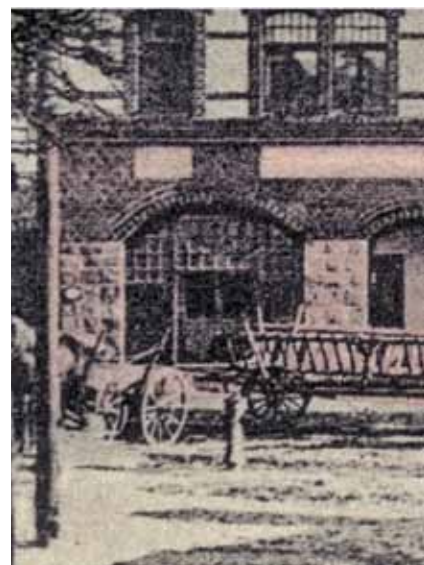
Wysoka Brama i zabudowania obecnej ul. Konstytucji 3. Maja około 1910 r. Widoczny hydrant sieci wodociągowej.
