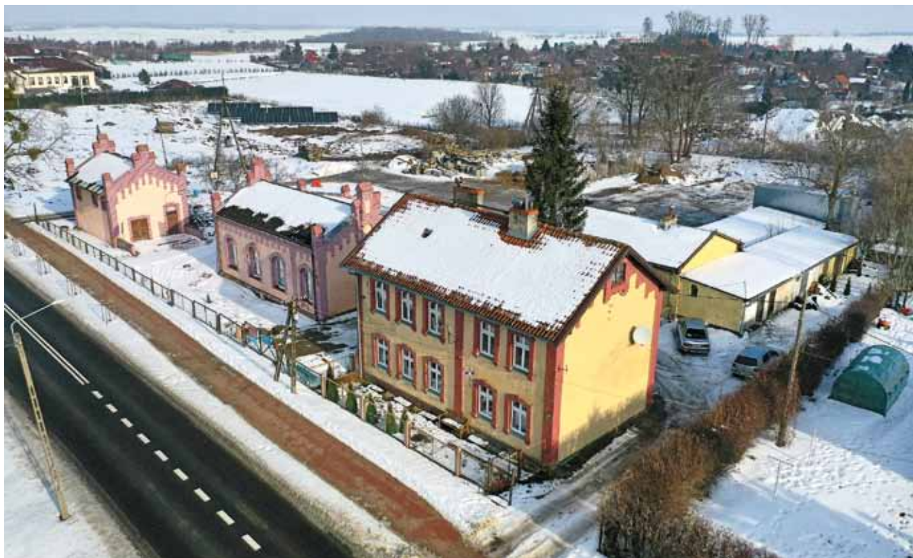
Obiekty obecnego Przedsiębiorstwa Wodociągów i Kanalizacji Sp. z o.o. przy ul. Dąbrowskiego. Na pierwszym planie trzy zachowane budynki dawnego Wasserwerku. Stan współczesny. Fot. M. Misztal.
