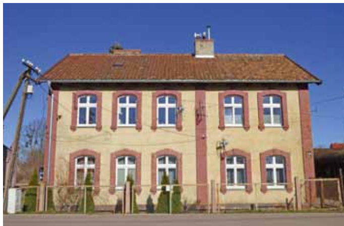
Rozbudowany dawny budynek mieszkalny kierownika Wasserwerku. Stan współczesny.
