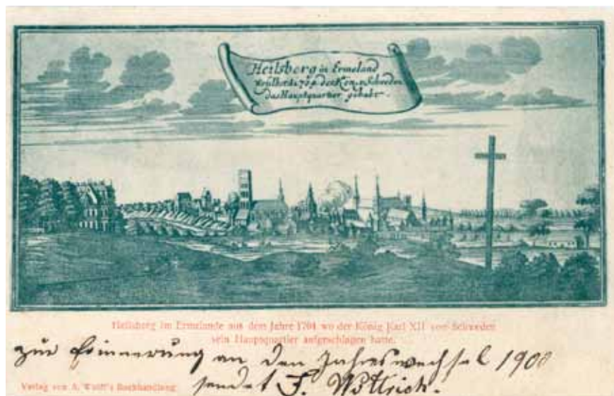
Panorama Lidzbarka od strony południowej z 1704 r. Miedzioryt J. Lithena. W lewym rogu widoczny zburzony przez Szwedów w 1704 r. pałac letni biskupa warmińskiego Jana Zbąskiego. Na prawo od pałacu rozciąga się Eckertsberg, skąd czerpano wodę do lidzbarskiego wodociągu.
