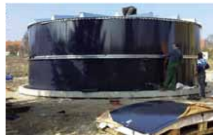
Prace przy modernizacji głównej Stacji Uzdatniania Wody „Zachód” w Lidzbarku Warmińskim przy ul. Przystaniowej (2015).
