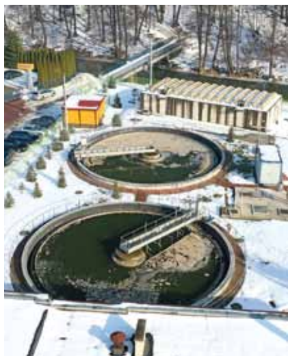
Lidzbarska oczyszczalnia ścieków oddana do użytku w listopadzie 2013 r. Fot. M. Misztal.
