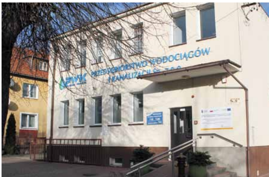
Siedziba Przedsiębiorstwa Wodociągów i Kanalizacji w Lidzbarku Warmińskim przy ul. Marszałka Józefa Piłsudskiego 18.
