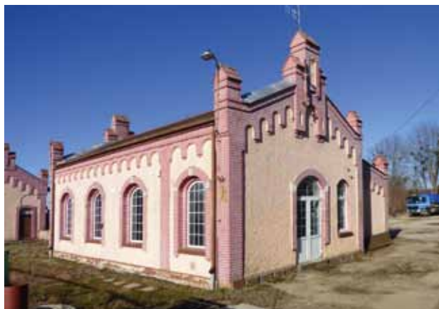
Dawna stacja pomp i odżelaziarka (Maschinen und enteisenungsanlage). Stan współczesny.
