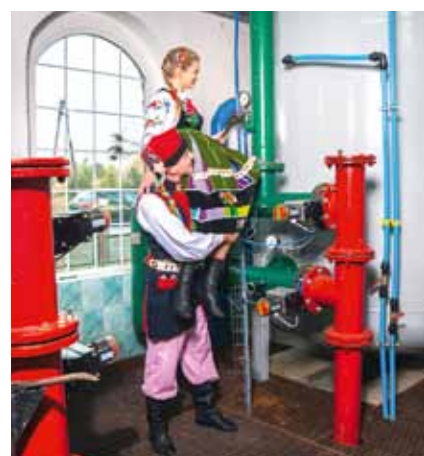
Nowoczesną lidzbarską oczyszczalnię ścieków promuje Zespół Tańca Ludowego „Perła Warmii”. Fot. Radosław Niemczynowicz.
