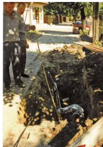
Rok 1985. Usunięcie awarii wodociągu śr. 300 mm, przy ul. Poniatowskiego w Lidzbarku Warmińskim. Wykop ręczny. W tle służbowy Żuk. Pracują monterzy Dariusz Tamkun i Andrzej Koźlik. Fot. Józef Kocęba.
