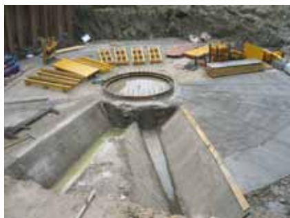
Prace przy modernizacji oczyszczalni miejskiej w Lidzbarku Warmińskim.
