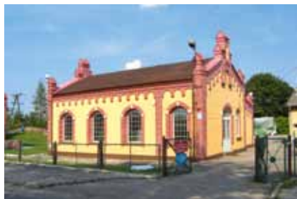
Stacja Uzdatniania Wody „Północ” przy ul. Jarosława Dąbrowskiego w Lidzbarku Warmińskim.
