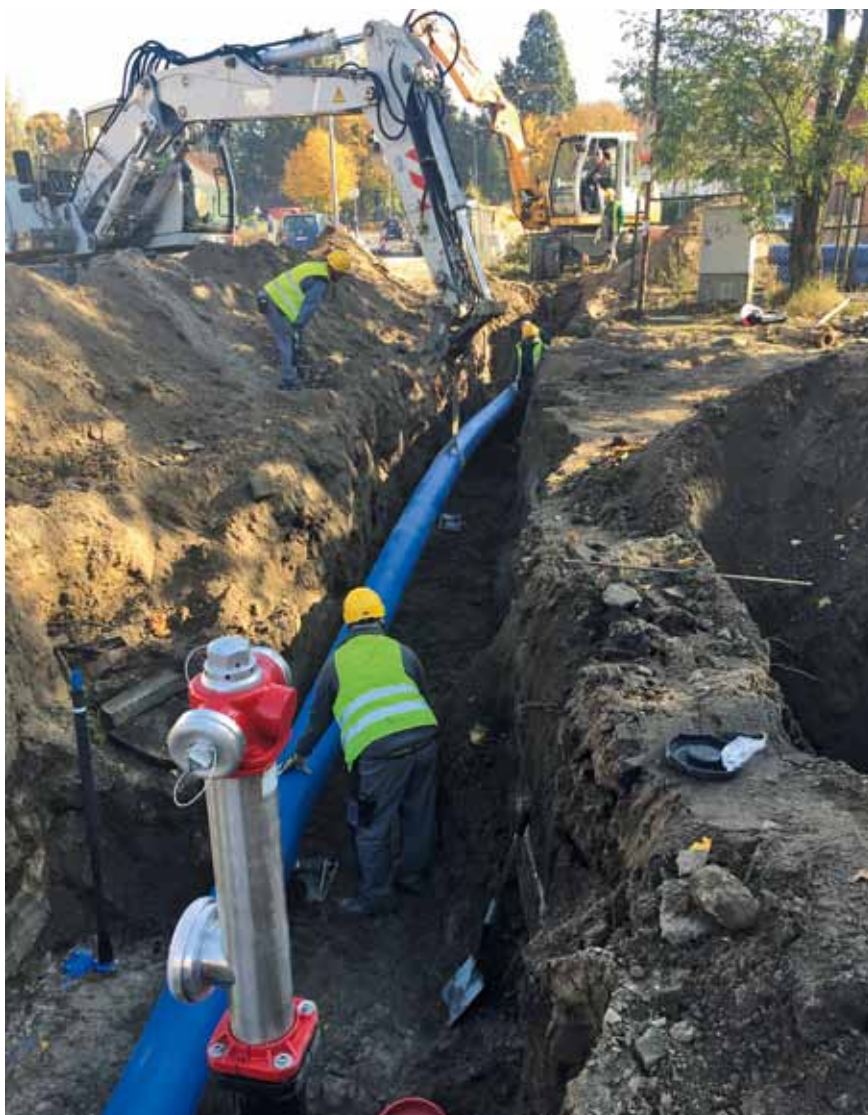
W związku z budową ronda w ul. Kard. Stefana Wyszyńskiego, PWiK Sp. z o.o. podjęło decyzję o wymianie sieci DN 300 (długość odcinka sieci 90 mb) na odcinku: nowo wybudowane rondo – ul. Warmińska oraz o wymianie sieci wodociągowej DN 90 (długość sieci 250 mb) na odcinku od nowo wybudowanego ronda do budynku nr 6 w ul. Bartoszyckiej. Inwestycja została sfinansowana ze środków własnych PWiK (2018).
